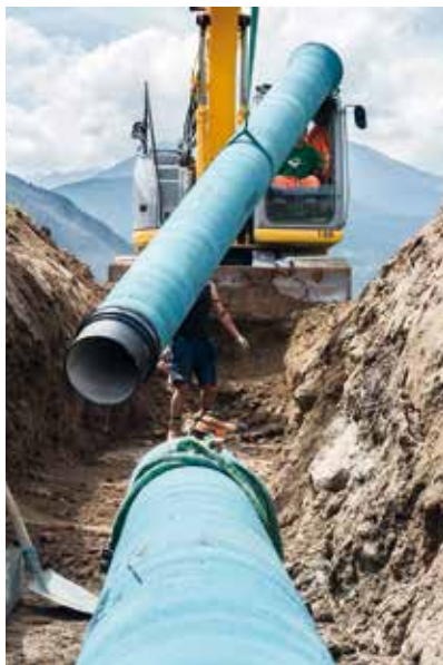
Verlegungsarbeiten der duktilen Gussrohre
