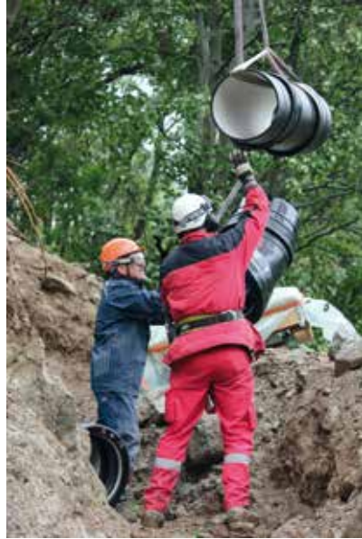
Um einen möglichst effizienten und ressourcenschonenden Leitungsbau zu gewährleisten, wurden die Rohre und Formstücke per Helikopter transportiert
