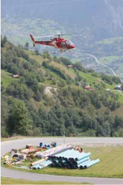
Um einen möglichst effizienten und ressourcenschonenden Leitungsbau zu gewährleisten, wurden die Rohre und Formstücke per Helikopter transportiert
