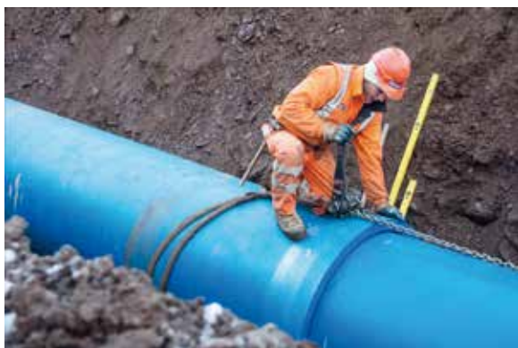
Verlegung der Rohre per Kettenzug
