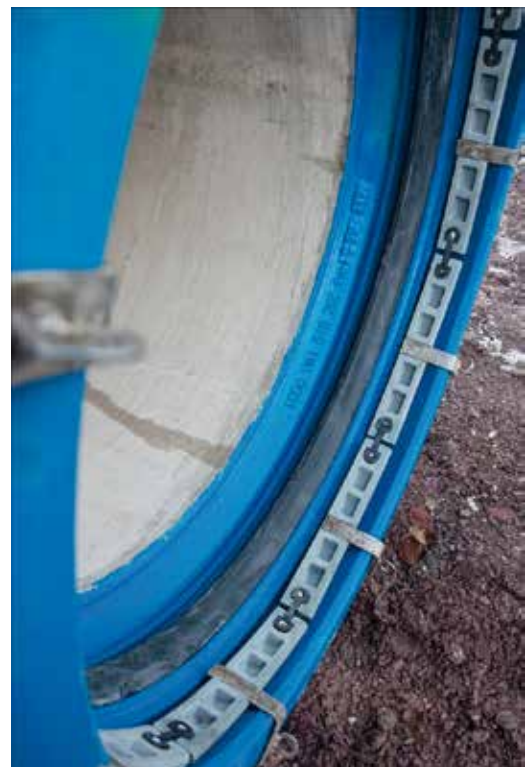
Rohr DN 1000 mit Schubsicherung und Dichtung
