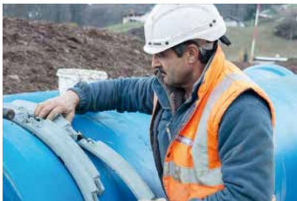
Befestigung der Schubsicherung TIS-K
