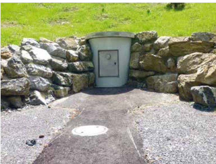
Die neue Brunnenstube des Typs «Aquaniro» mit inneren Ausbauten aus Chromstahl.
