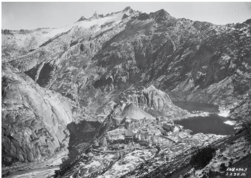
Übersicht der Bauinstallationen, Spitalamm, Grimselnollen, altes und neues Hospiz, Grimselsee, umgelegte Grimselstrasse, Gerstenhörner.
