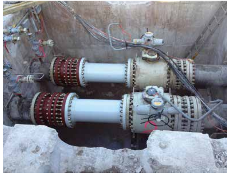
Nach erfolgreichem Einbau
