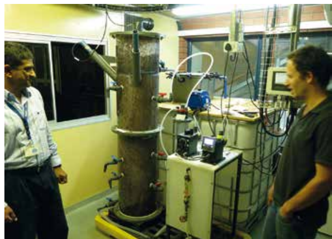
Abb. 6: Pilotanlage im Kundenzentrum von Durban's Wasserwerken. Foto: Bastian Etter
