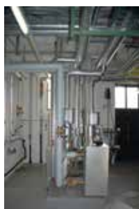
Die Weishaupt-Erdgas-Brenner G 50 modulieren im Verhältnis 1 : 3
