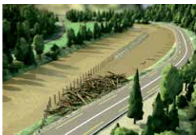
Während die Sihl frei fliesst, hält der Rechen das Schwemmholz zurück.
