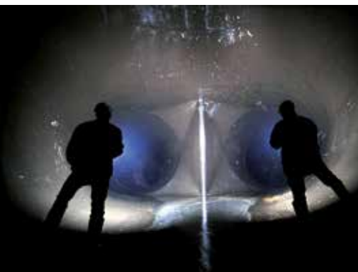
Foto: picture-alliance/ dpa Durch die rund acht Meter hohen Unterwasserverteilstollen des Pumpspeicherwerks Goldisthal strömen die Wassermassen aus den Turbinen kommend in das Unterbecken
