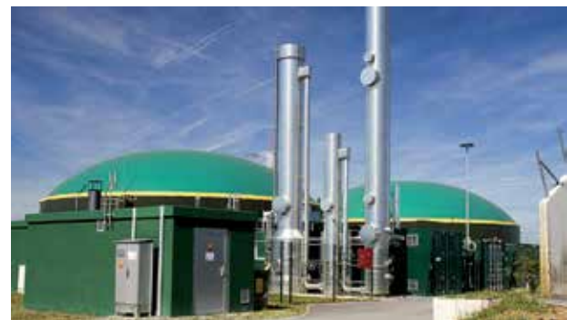
Biogas wird zu Strom verheizt, die Abwärme bleibt meist ungenutzt (Bildquelle: picture alliance)
