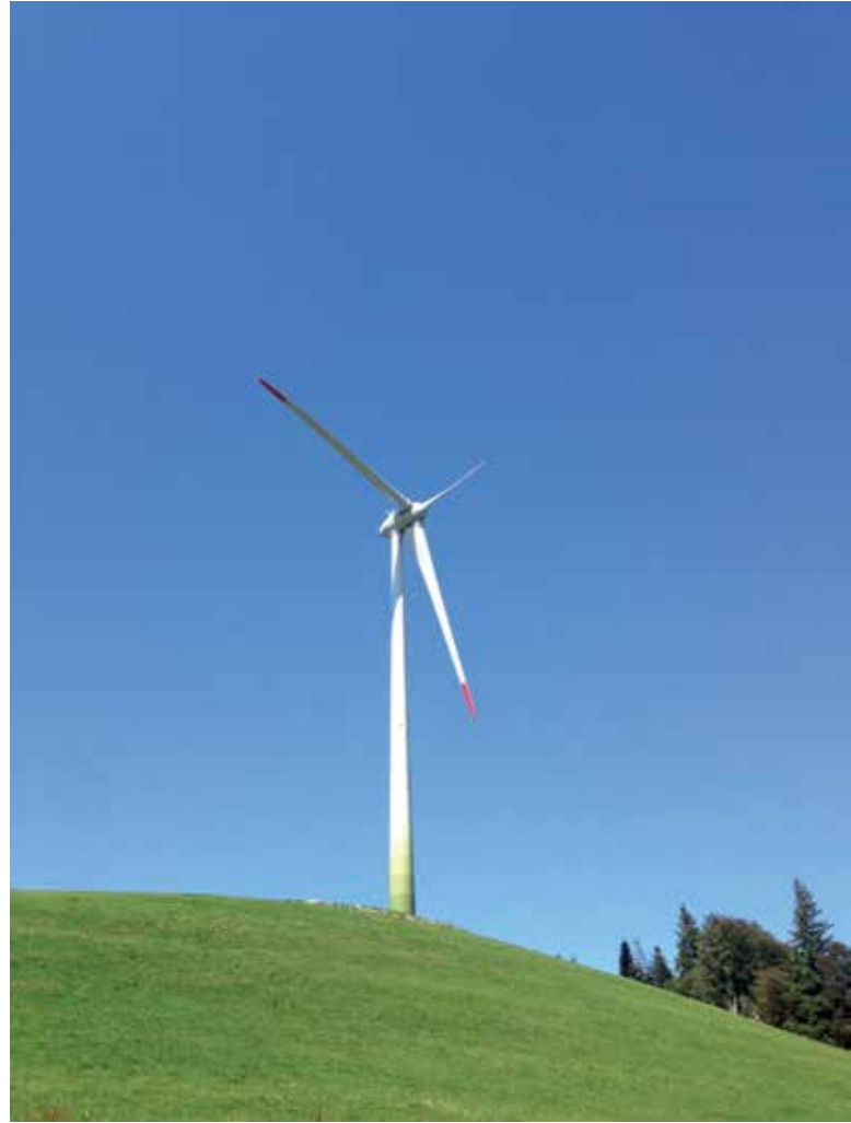
Nach Abschluss der Bauarbeiten
