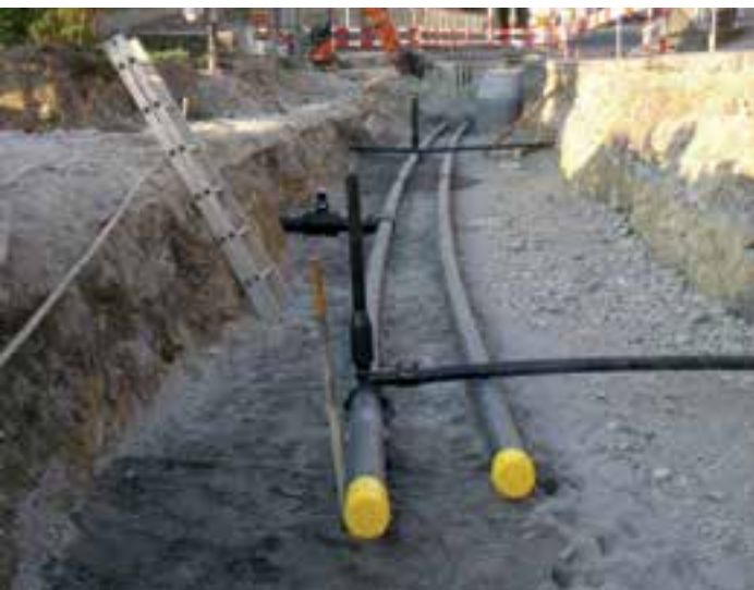
Hausanschlüsse werden mit FRIALOC-Druckanbohrventilen abgezweigt.
