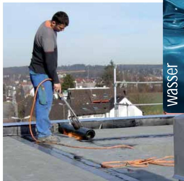
Jährlich werden in der Schweiz rund 5 Mio. Quadratmeter Flachdächer erstellt, mehr als die Hälfte davon mit Bitumenbahnen abgedichtet. Dank der Zusammenarbeit der Wasserforschung mit den Herstellern konnten die neuen Produkte nun so verbessert werden, dass bis 98% weniger Herbizide aus Bitumenbahnen in die Umwelt gelangen.
