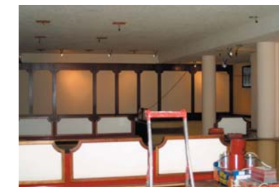
...und während dem Umbau.
