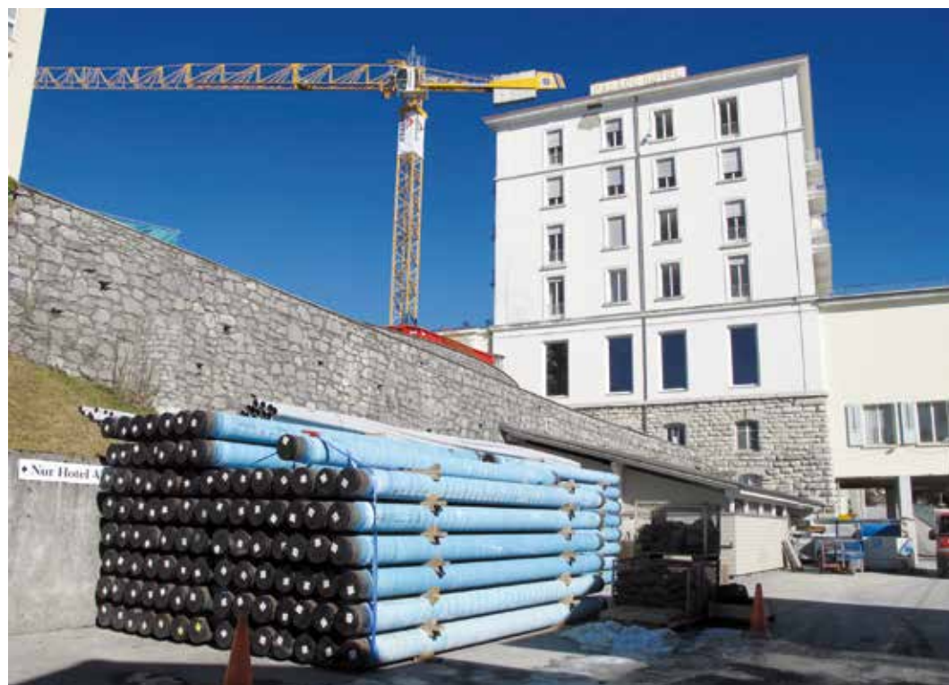
Lieferung der Rohre Livraison des tuyaux
